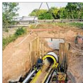
Zweimal müssen die Kanalbauarbeiter in Kall Bahnlinien unterqueren. (Bild: Züll)
